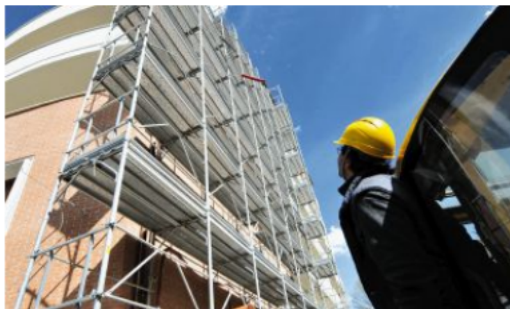
Un operaio edile al lavoro
